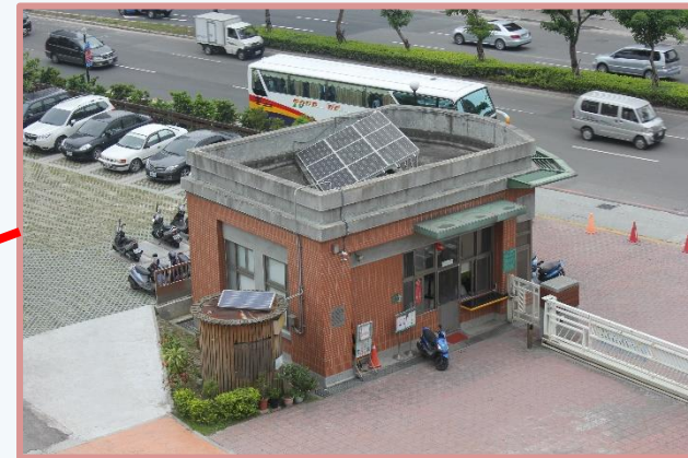
警衛室上方設置3KW太陽能板
