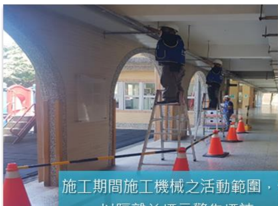
施工人員全程穿著施工背心及配戴安全帽；施工前進行施工前教育
